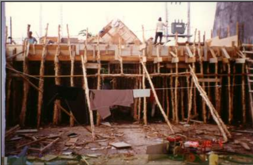
Renovasi yang ke tiga gedung GBKP tahun 1996 di Jl.HR.Muhammad 275 Surabaya
