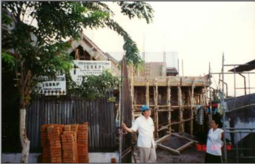
Renovasi yang ke tiga gedung GBKP Surabaya tahun 1996 Nd.Hendry Sembiring dengan Petrus Sunarto (pemborong)
